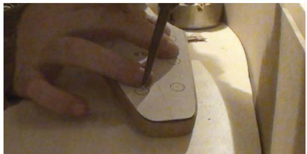
Löcher für die Mechaniken werden gebohrt.
